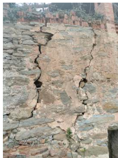
Esquerda de major afectació a la façana oest Imatge general i imatge de detall
