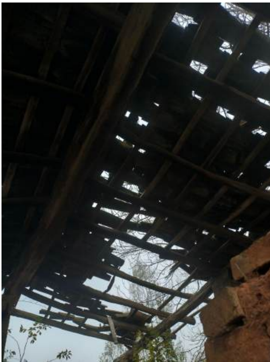
Detalls de l'estat de conservació de l'embigat i de la coberta
