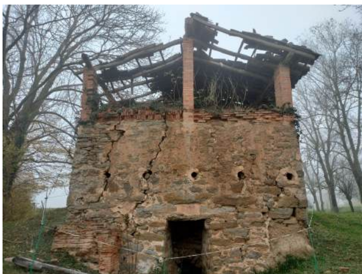
Esquerda de major afectació a la façana oest Imatge general i imatge de detall
