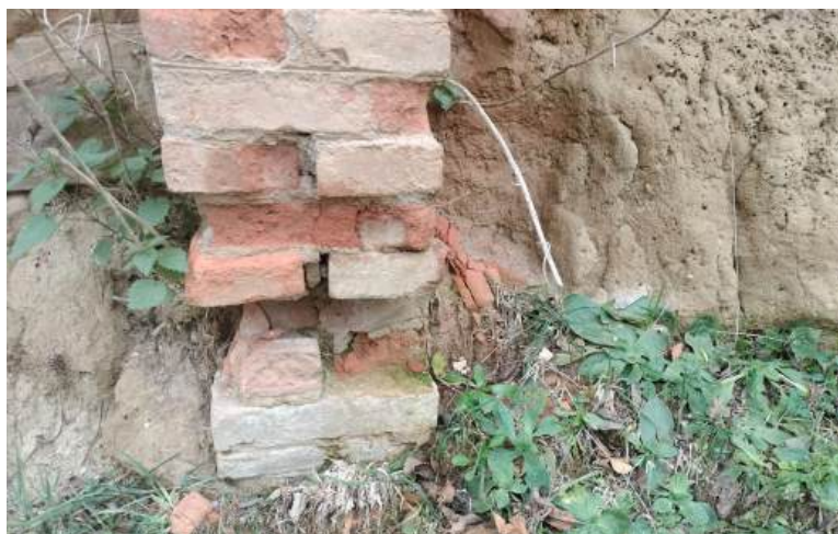
Detall estat de conservació d'un dels pilars de maons
